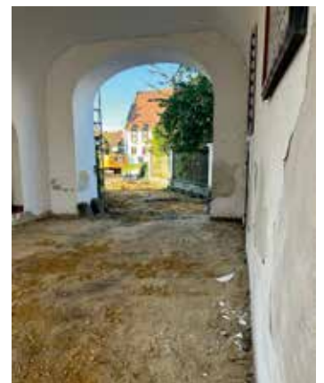
Baustelle Torbogen: Keine Durchfahrt mehr möglich.
