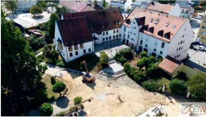
Der Baufortschritt am Rathausvorplatz gut sichtbar aufgenommen per Drohne. (Foto: Ebner)
